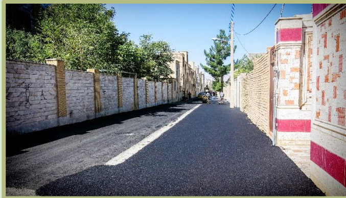
روکش و ترمیم آسفالت
