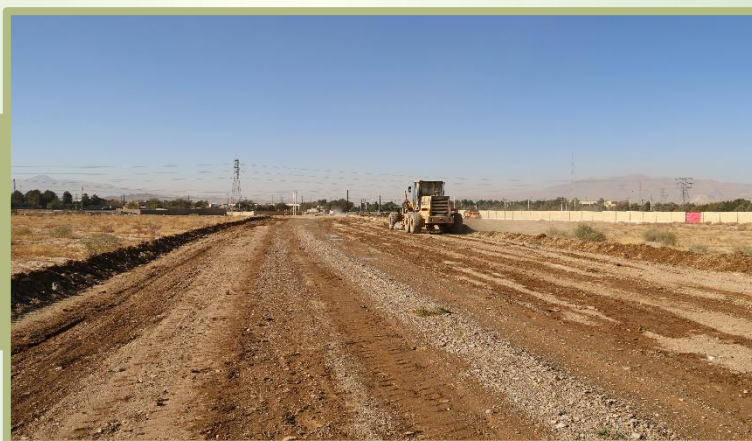
ادامه عملیات زیرسازی منطقه آذرآباد
