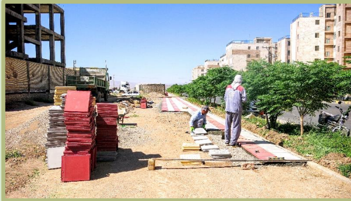
نصب ۴۰۰۰ متر مربع بلوکفرش
