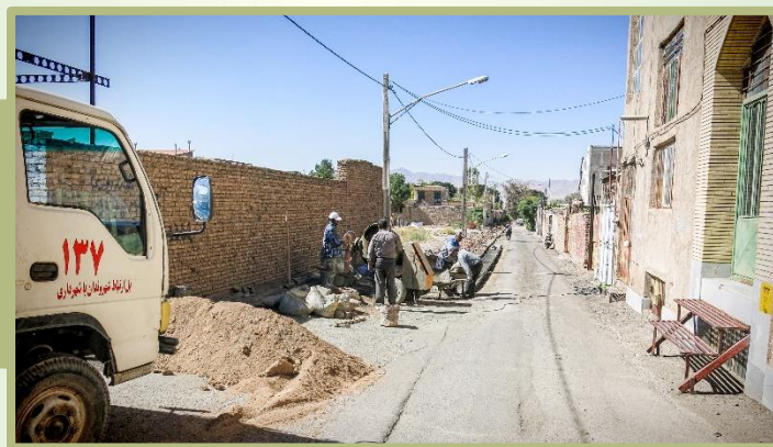
ساخت و ترمیم کانیوو
