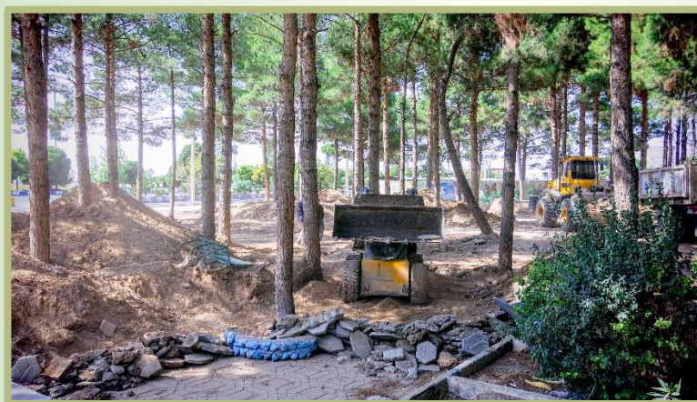
آغاز عملیات بهسازی پارک لاله
